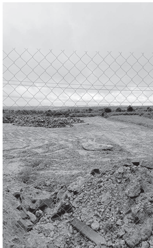
У строительной площадки возле д.Яльгелево нет адреса объекта.
