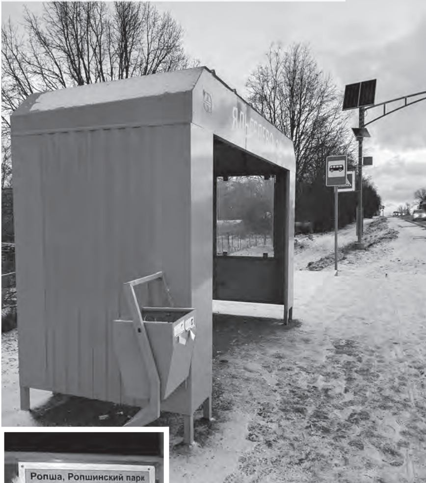
Новый автобусный павильон в деревне Яльгелево.
