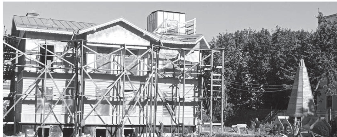
Восстановление дома 10 на улице Еленинская в Ломоносове вышло на заключительный этап.
