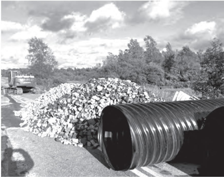
Завершены ремонтные работы на дороге Ропша – Оржицы.
