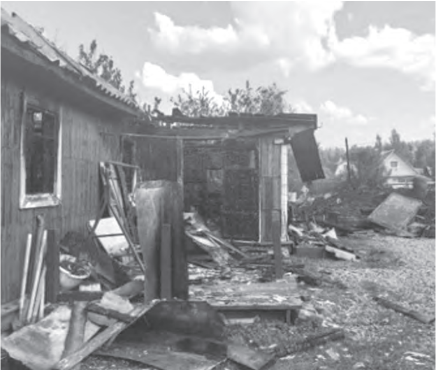
Последствия налёта беспилотников в Ломоносовском районе.
