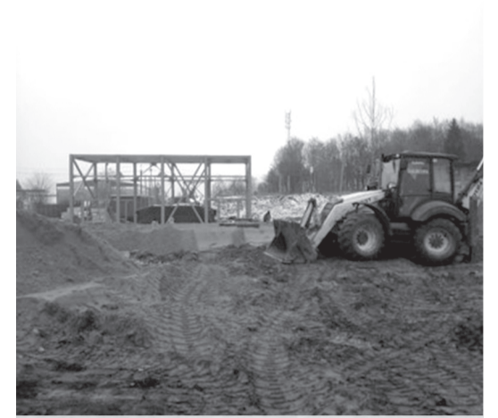
Строительство водозабора в Кипени.
