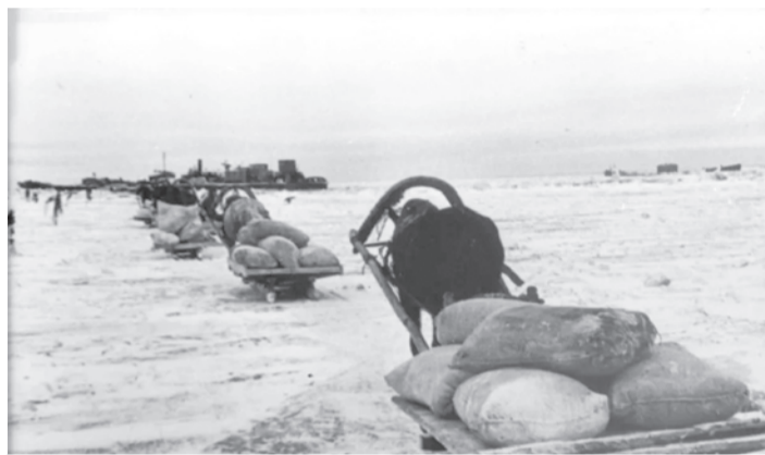
Конный обоз с зерном на Ладожской трассе, декабрь 1941 года.
