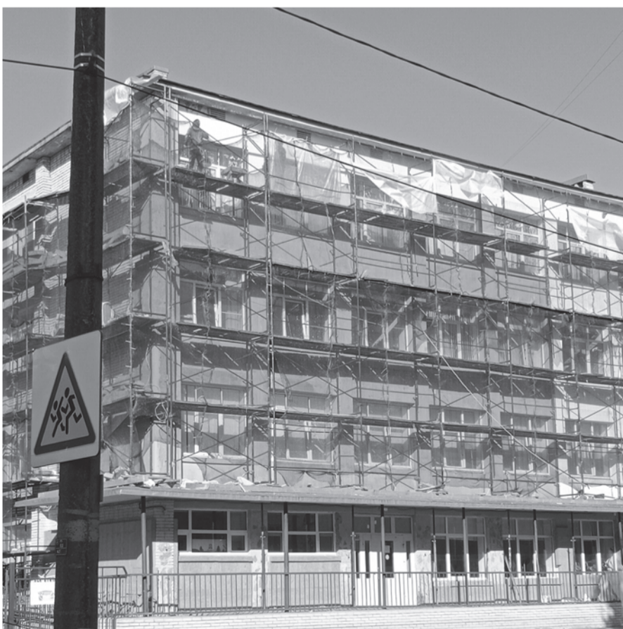
Гимназия № 426 в Ломоносове – в строительных лесах.
