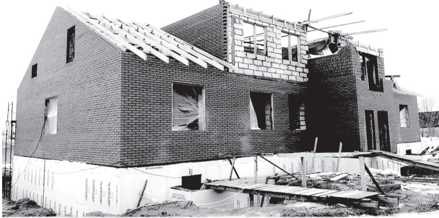
Строящиеся объекты здравоохранения в Ломоносовском районе.
